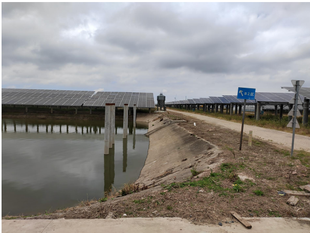
本项目光伏区现状
