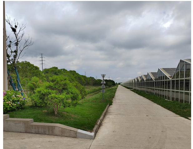
本项目开关站现状
