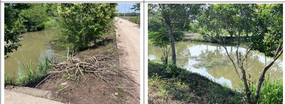
前进中心河 5 号桥两侧有水花生和岸域堆载。
