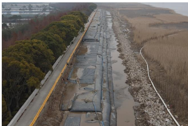
图 25 充泥管袋施工实景图
