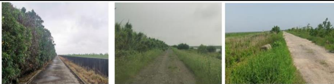
图 9 工程范围内海塘现状照片
