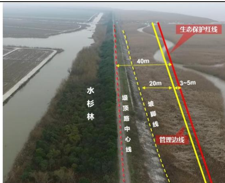
图 33 本项目现状大堤周边情况航拍图
