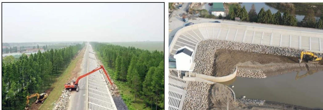
图 27 陆上抛石护脚施工现场照片（一期、二期工程）
