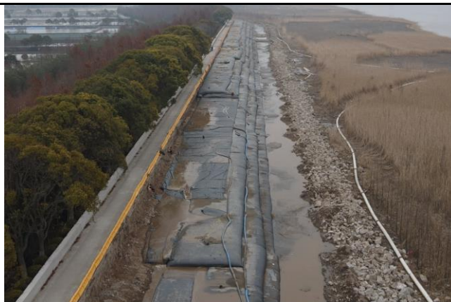
图 26 充泥管袋施工实景图
