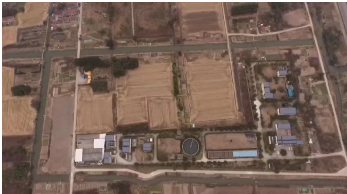
图 3-11 污水厂布局现状航拍图
