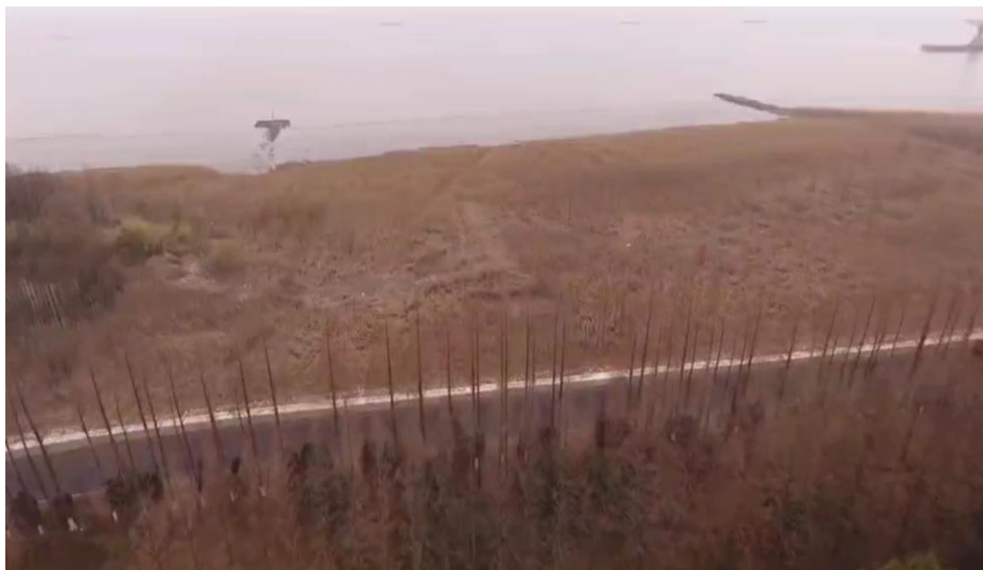
图 5-3 排污口附近大堤航拍图 1
