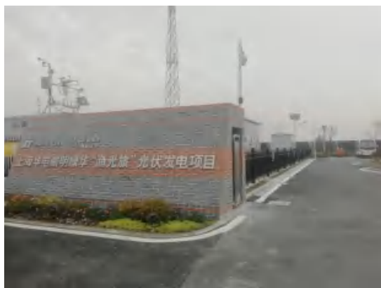
华电崇明绿华 44MW 渔光互补光伏发电项目
