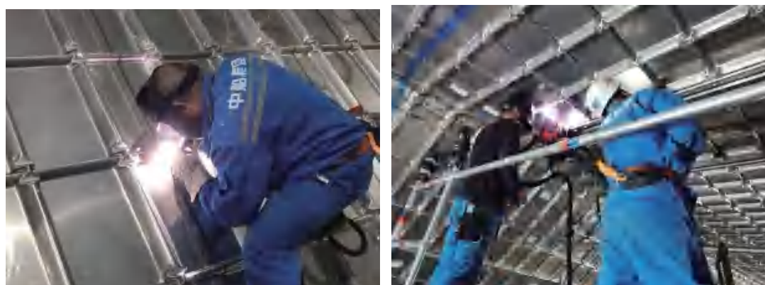
图 4.2-6 熔母焊操作照片
