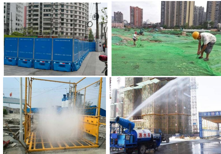
图 7.3-1 施工现场扬尘控制措施
