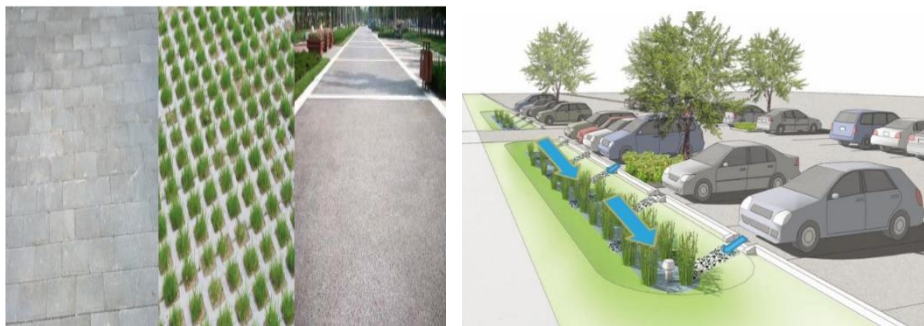
图 7.4-2 下沉式广场与透水铺装
