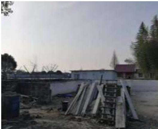
项目北侧现状（其中一户已拆迁）
