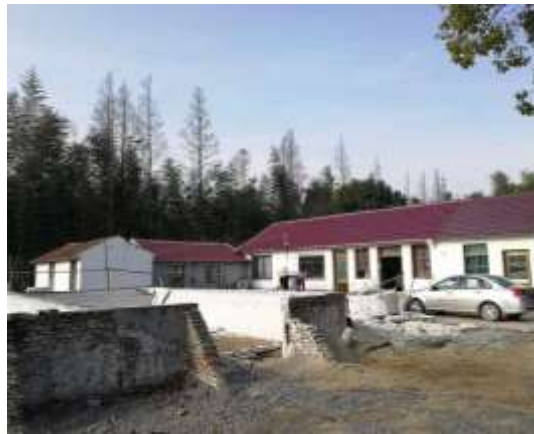
项目北侧现状农宅
